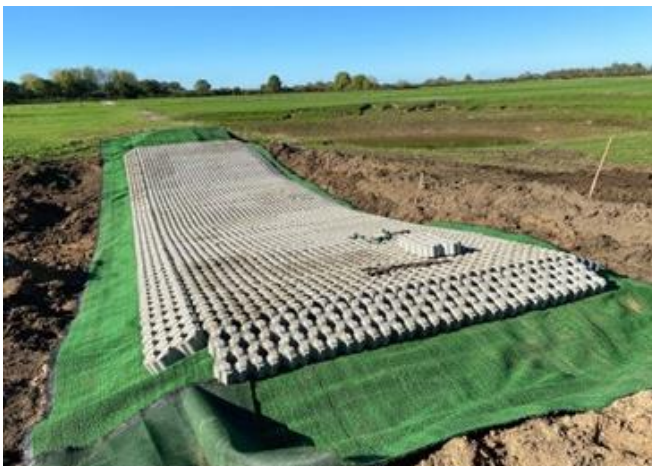
Plaatsing betonblokkenmat
